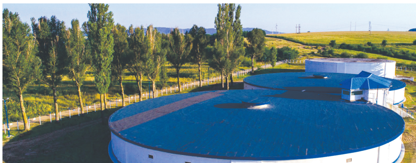
Rezervoare de înmagazinare a apei - Cuciur
